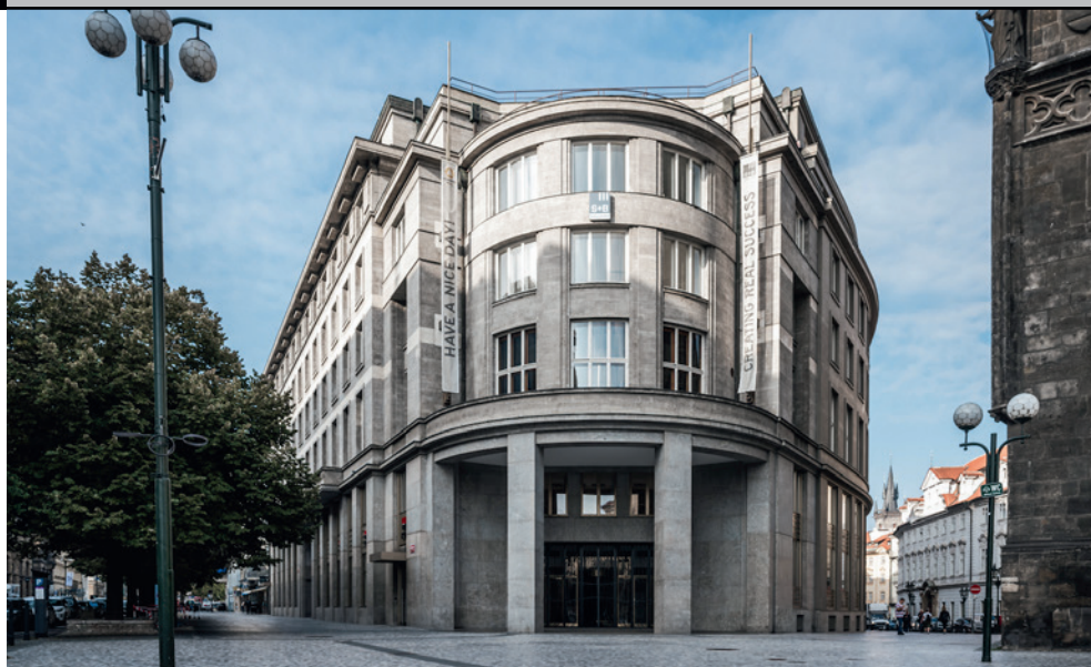
Via Una, Praha 1 ■ Multifunkční budovu na hlavní pražské nákupní třídě získala od investora Commerz Real společnost Trinity Bank ■ Grinity: Technické Due Diligence, transakční poradenství
